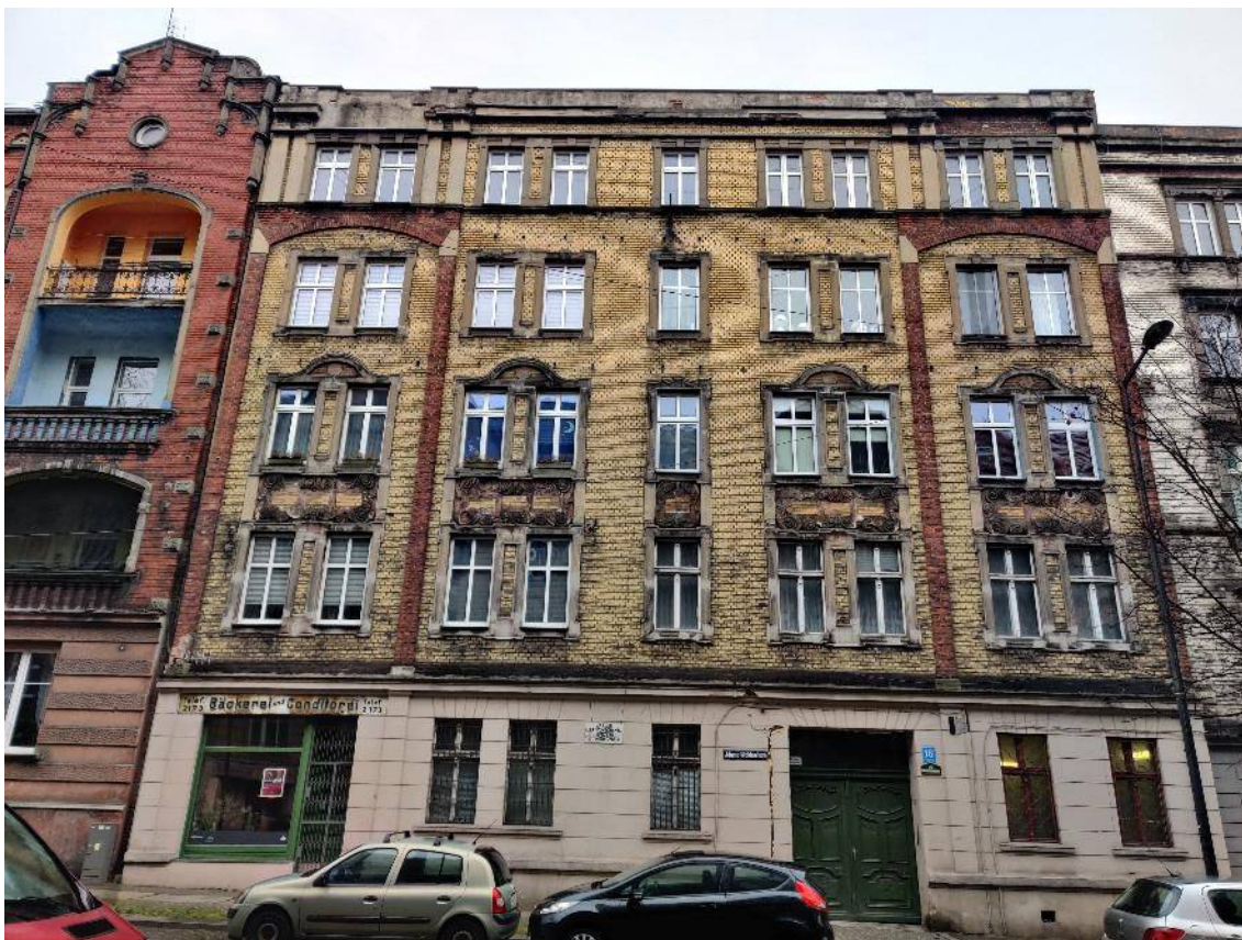
Rys. nr 2. Widok ogólny budynku – elewacja zachodnia [1.3].
